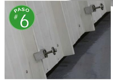
Coloque la primera fila de paneles fotovoltaicos en su lugar (no apriete la pestaña superior del kit solar).
