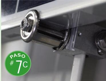
Continúe instalando los paneles AceClamp, Solar-Kits y PV en la misma secuencia para el resto de la matriz FV.
