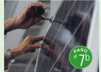
Regrese a la primera fila de kits solares, inserte el soporte final \* y apriételo a 100 in. Lbs. Esfuerzo de torsión.
