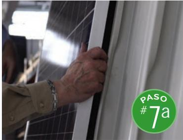
Instale los kits solares en la siguiente fila y apriete los postes de montaje a 100 in-lbs.
