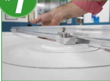
Pase a la siguiente sección de ocho (8) pies, repita el paso 7, coloque el nuevo riel Color Snap® deslizando los conectores del riel en ambos rieles.
