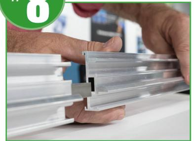
Termine sus secciones deslizando una tira de 2” de ancho del material del techo o la tira de color en las ranuras provistas en la cara del riel Color Snap®, superponiendo la siguiente sección de 8’.
